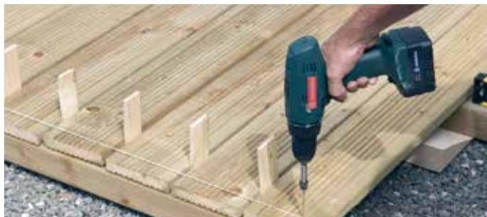
Nach dem Verschrauben schneiden Sie den Überstand rundum sorgfältig bündig ab (Kappschnitt) oder planen bewusst einen Überstand ein. Alternativ haben Sie auch die Möglichkeit, das bündig abgeschnittene Ende mit einer Diele zu verblenden. Anschließend fassen Sie die Schnittkanten mit einem Elektrohobel, einem Bandschleifer oder mit Schleifpapier an.
