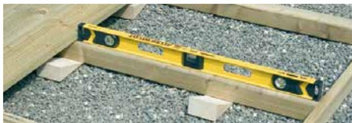
Als Untergrund eignet sich am besten Schotter/Splitt. Abtropfendes Regenwasser wird so schneller abgeführt. Ein vorher verlegtes Wurzelvlies verhindert, dass Unkraut durch die Zwischenräume wächst.
