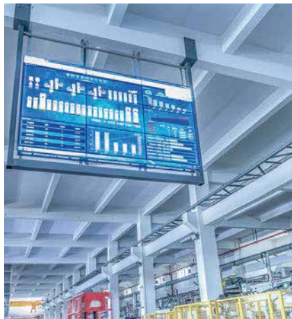
中央控制系统 Central Control System
