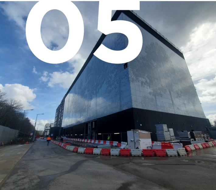
La modularité de nos systèmes a permis de faciliter l'installation en façade. Cette disposition a libéré l'espace disponible dans le bâtiment pour le Data Hall et a réduit le risque d'incendie en intérieur.
