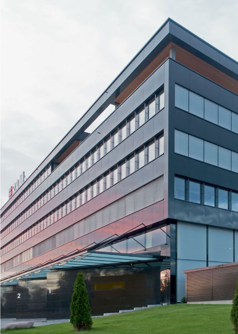
R&M Cube, le siège social de l'entreprise à Wetzikon, en Suisse.
