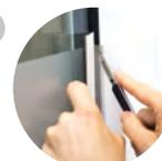
**Recoupez le film à un format inférieur de 2 mm à celui du vitrage afin qu'il ne touche pas l'encadrement, puis maroufflez de nouveau pour chasser les bulles d'air**
