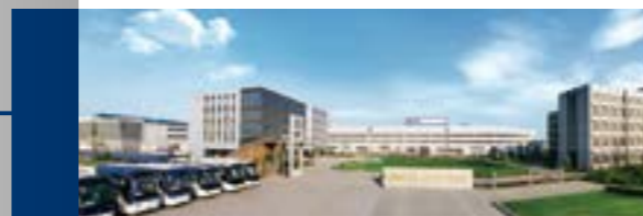
Enric 安瑞科 CIMC ENRIC 石家庄安瑞科气体机械有限公司 Shijiazhuang Enric Gas Equipment Co., Ltd.
