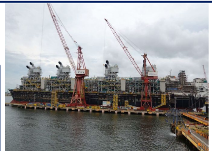
FLNG : On site: Q1- 2024
