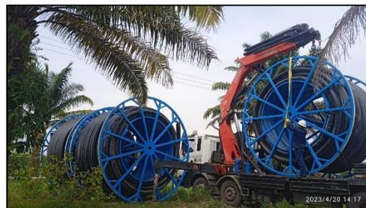
Instalación Tubería Flexible – Flexsteel 6in – 1500 psi. Reparación de línea.
