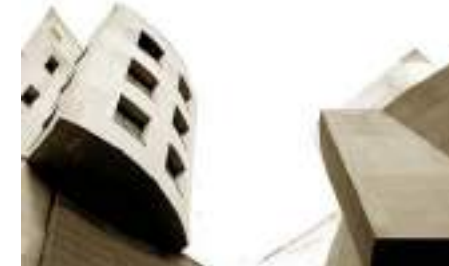
Cinémathèque française Construction 1994
