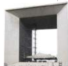
Grand Arc de la Defense Construction 1985
