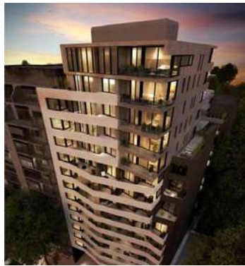
Argentina. Dome Green Soho
