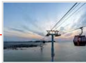
제부도 해상 케이블카 왕복 관광 Return to the port by cable car
